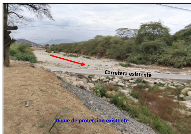
Figura N° 5. Punto final del tramo de intervención, se observa el cruce de una carretera asfaltada afectada y aguas abajo una protección con enrocado en la margen derecha del río Yapatera, en Chulucanas.
